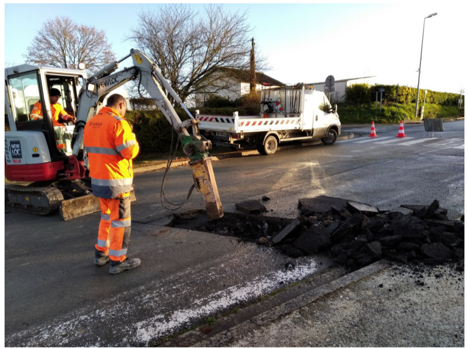
Effacement des réseaux de la rue de la Gare
